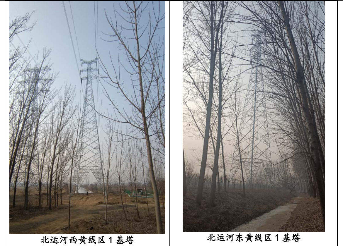
图 4-2 本工程变电站及输电线路沿线情况
