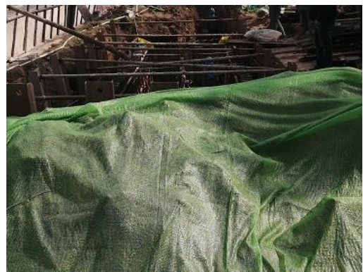
电缆施工土壤分层堆放照片
