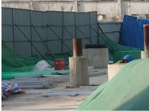
施工期围挡、地面硬化照片
