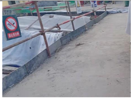
施工期物料苫盖、地面硬化照片
