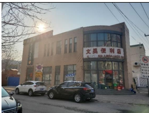
变电站东侧（商业用房）
