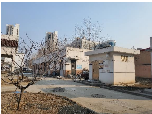
雨水泵站附属用房
