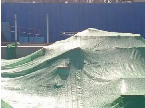
施工期围挡、苫盖照片
