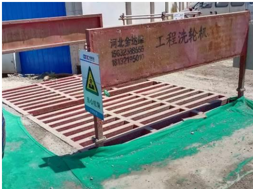
施工期车辆冲洗装置照片
