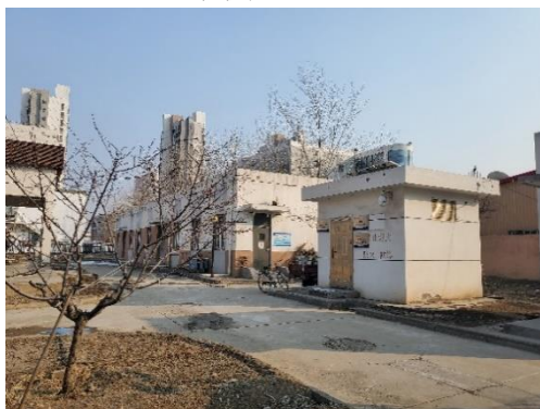
变电站西侧（雨水泵站）
