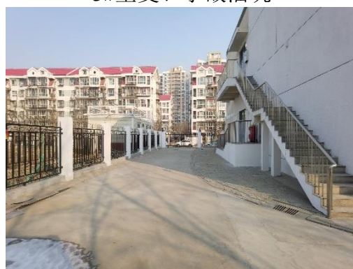
站内地面硬化情况
