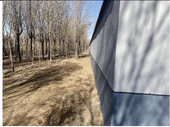
图 8-10 变电站外东南侧
