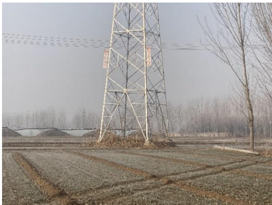
图 8-13 塔基占地恢复情况
