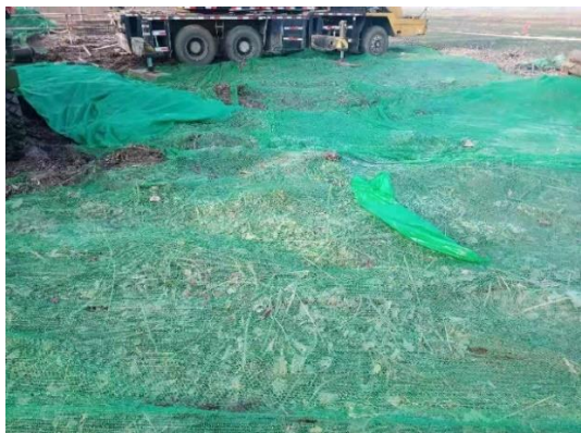
图 8-21 施工现场苫盖
