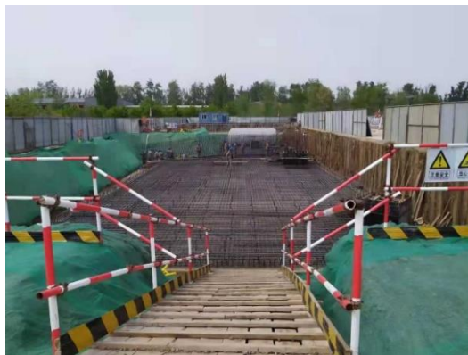
图 8-22 施工现场围挡
