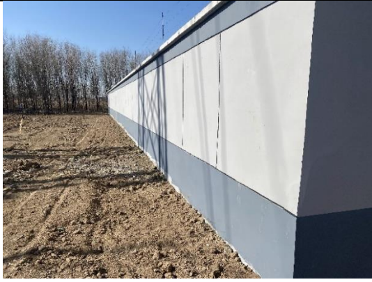
图 8-9 变电站外西南侧
