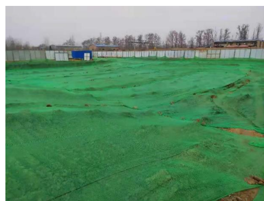
图 8-20 施工现场苫盖
