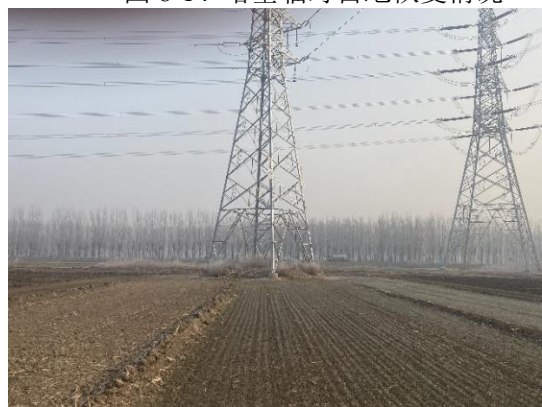
图 8-16 塔基临时占地恢复情况
