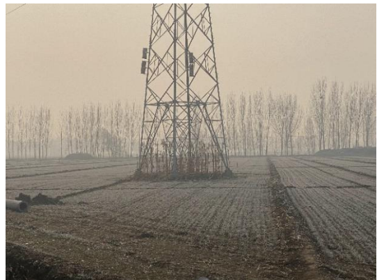
图 8-14 塔基临时占地恢复情况
