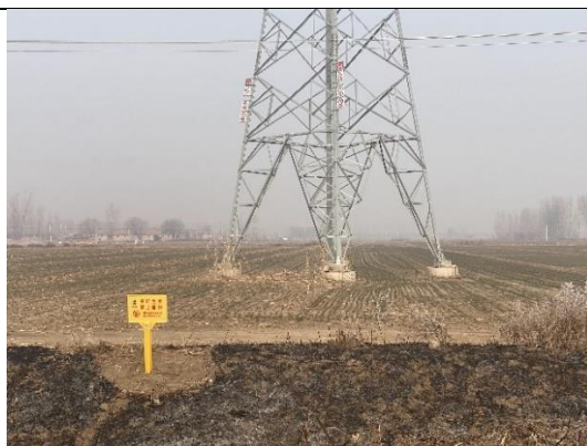
图 8-18 塔基临时占地恢复情况
