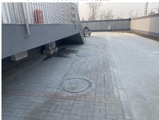
图 8-3 变电站内西北侧
