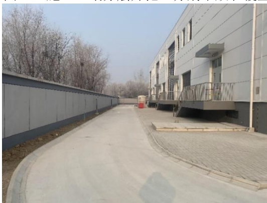
图 8-4 变电站内东北侧
