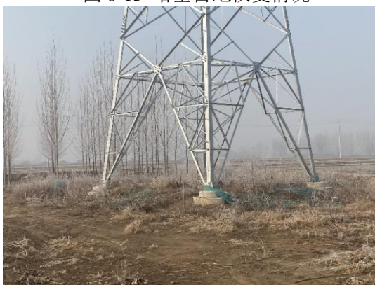
图 8-15 塔基占地恢复情况
