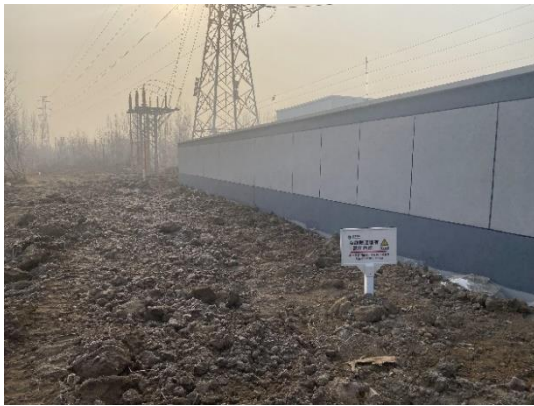
图 8-11 电缆临时占地恢复情况
