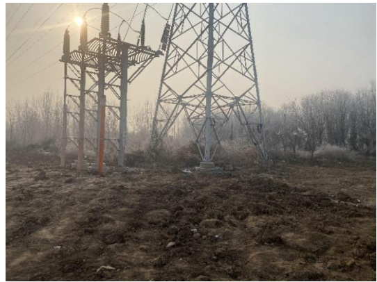
图 8-12 电缆终端塔临时占地恢复情况
