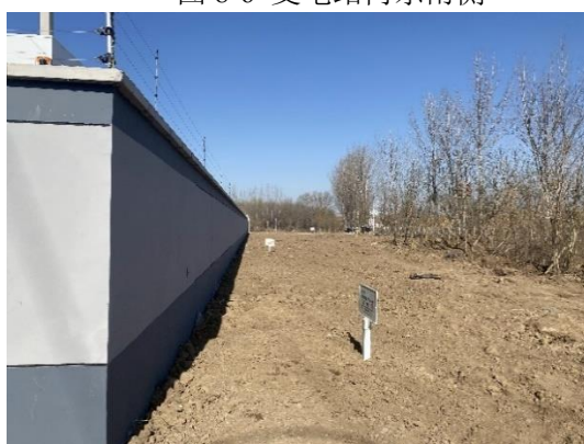
图 8-8 变电站外东北侧
