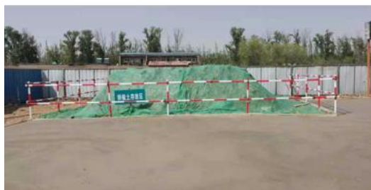
图 8-2 施工土壤分层开挖、分别堆放和覆盖
