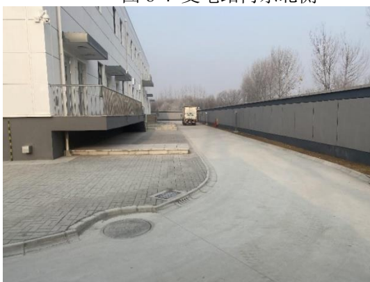
图 8-6 变电站内东南侧
