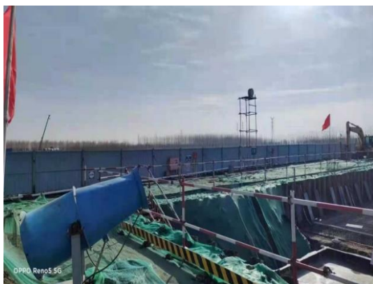
图 8-19 施工现场防尘
