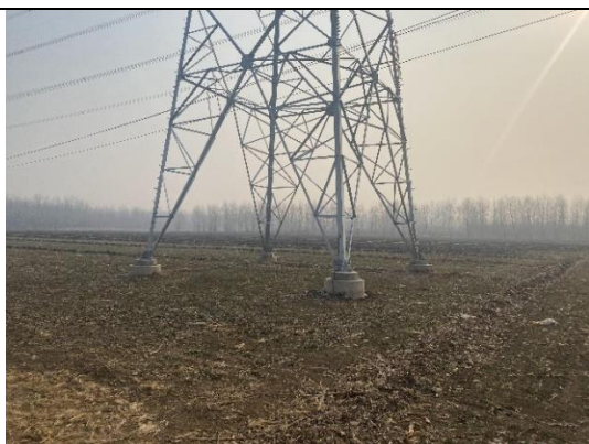
图 8-17 塔基占地恢复情况
