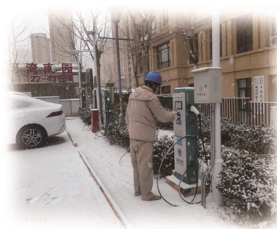
开展充电桩设备检查
