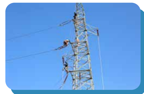
完成科技城110千伏送出工程切改工作 ▲
