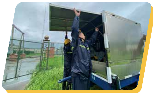
▲ 在交流110千伏王御史变电站开展雨后站内排水
