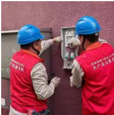
▲ 顺利完成供电辖区内老旧电表集中更换任务
