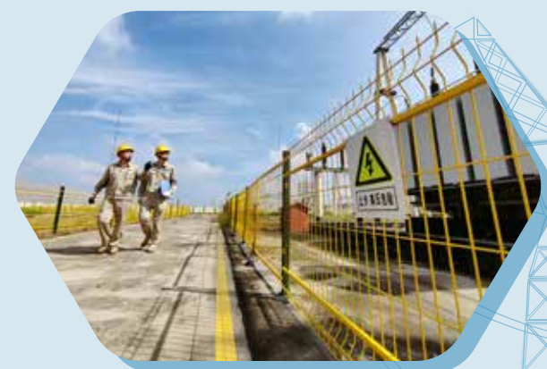
国庆等重要保电前夕，做好设备巡视全覆盖
