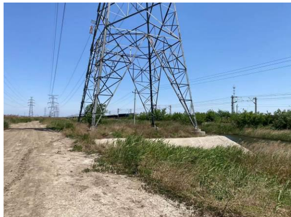
塔基下方绿化恢复情况
