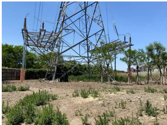
塔基下方绿化恢复情况
