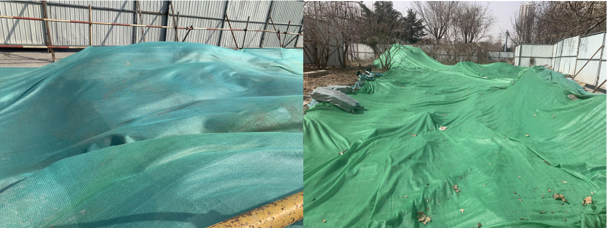
图 8-3 施工现场照片(1)
