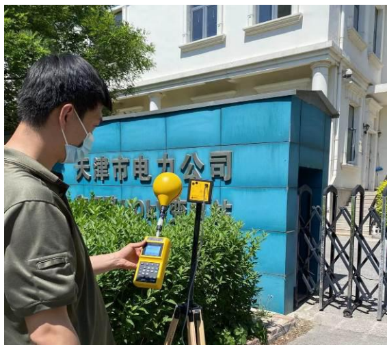
和畅路 110kV 变电站
