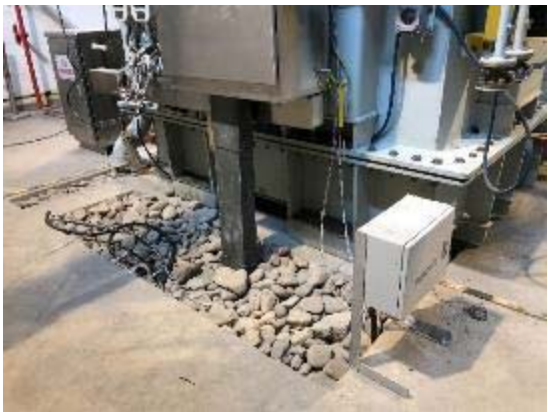
主变压器下方事故油坑
