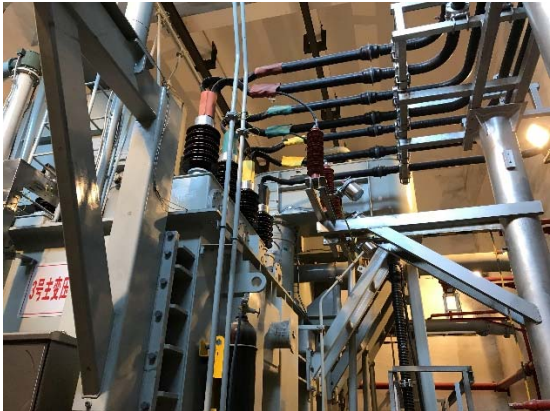
主变压器户内布置
