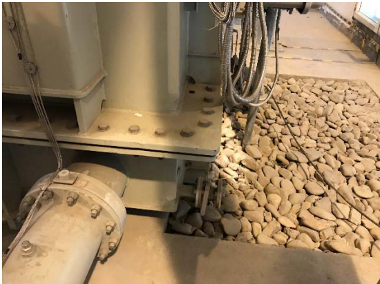
主变压器下方事故油坑
