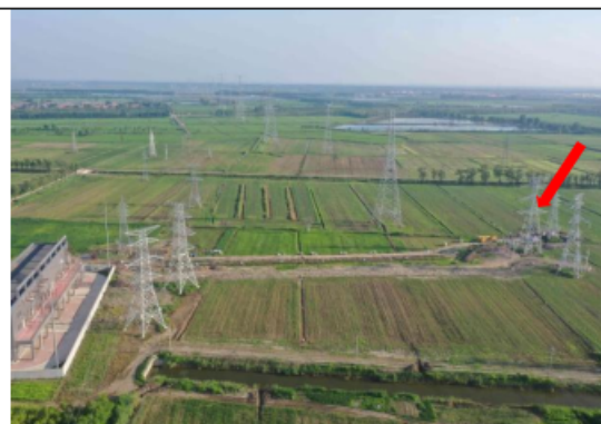
张岗铺变电站外线路
