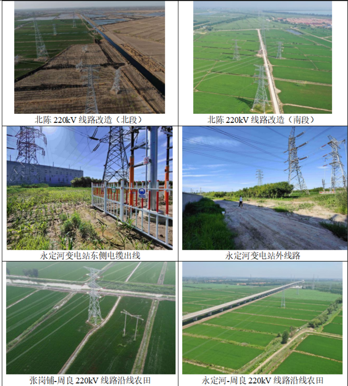
图 4-2 本工程建设情况及周边环境
