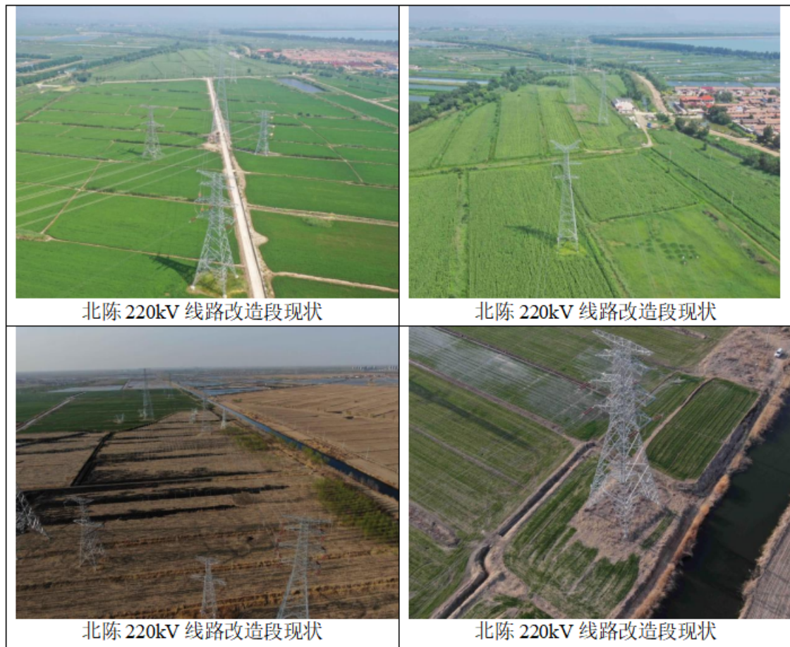
图 8-2 北陈 220kV 线路改造工程施工迹地清理和恢复后现状
