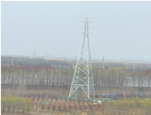
图 8-7 引滦水源输水河道黄线区内塔基施工区恢复现状
