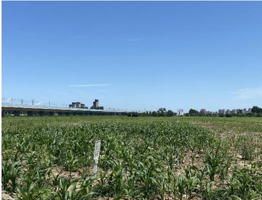
图 8-5 电缆施工区恢复现状 1
