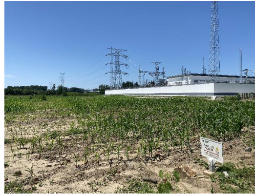
图 8-6 电缆施工区恢复现状 2
