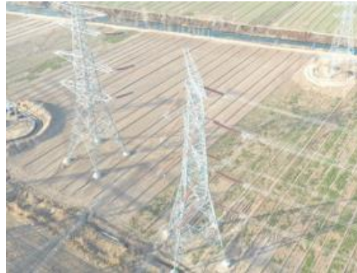
图 8-8 京唐铁路北侧塔基施工区恢复现状 1
