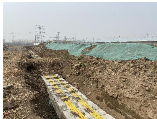
图 8-2 施工期生态保护措施 2
