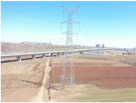
图 8-9 京唐铁路北侧塔基施工区恢复现状 2
