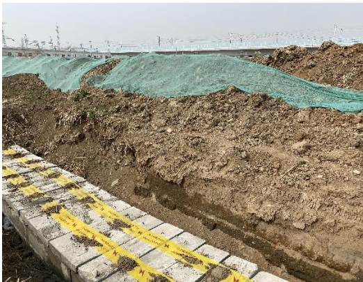
图 8-1 施工期生态保护措施 1
