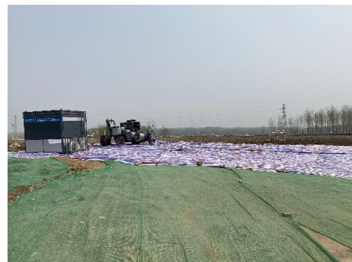
图 8-14 施工期绿网覆盖
