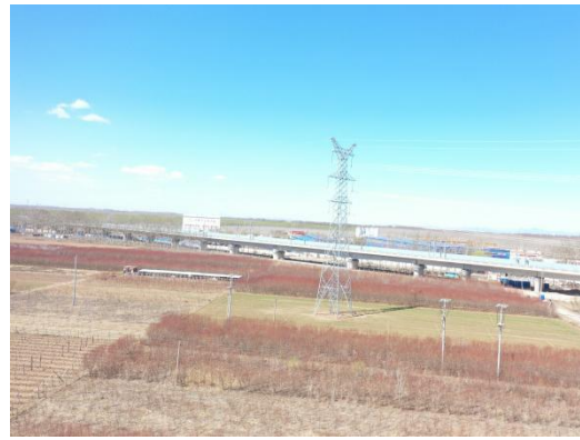
图 8-10 京唐铁路北侧塔基施工区恢复现状 3
