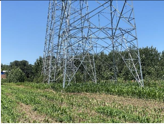
图 8-3 塔基施工区恢复现状 1
