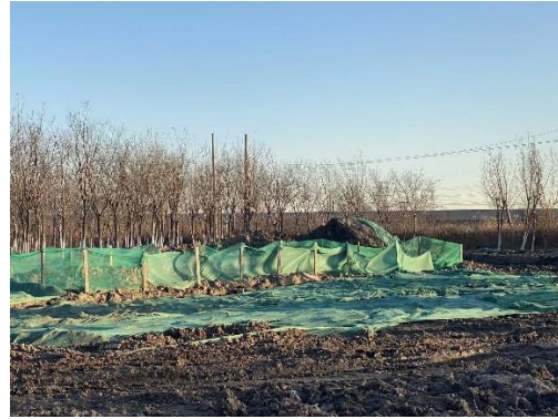
图 8-16 施工期绿网覆盖
