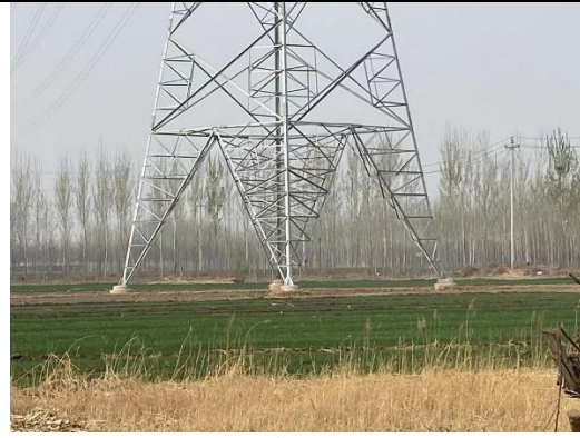
图 8-6 塔基施工区恢复现状 4
