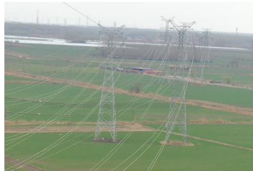
图 8-10 引滦水源输水河道黄线区内塔基施工区恢复现状 2
