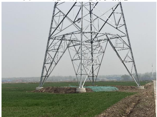
图 8-3 塔基施工区恢复现状 1
