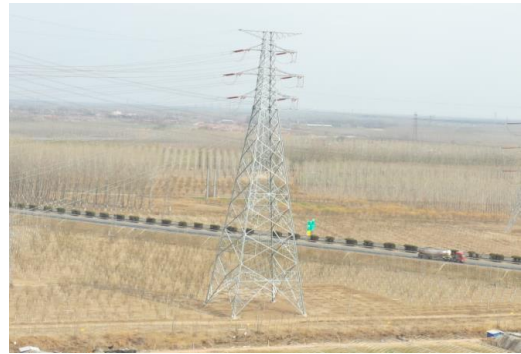
图 8-8 津蓟高速公路东侧塔基施工区恢复现状
