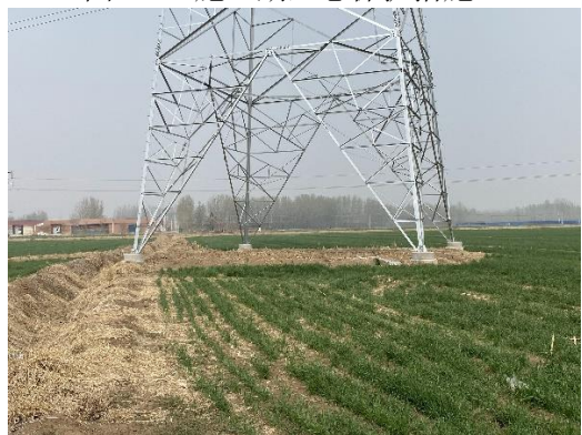
图 8-4 塔基施工区恢复现状 2
