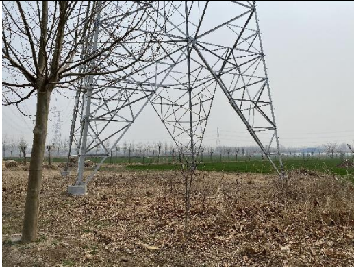
图 8-5 塔基施工区恢复现状 3
