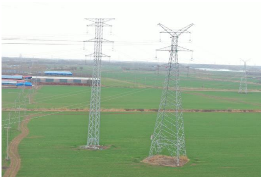
图 8-9 引滦水源输水河道黄线区内塔基施工区恢复现状 1
