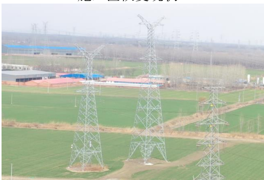
图 8-11 引滦水源输水河道黄线区内塔基施工区恢复现状 3
