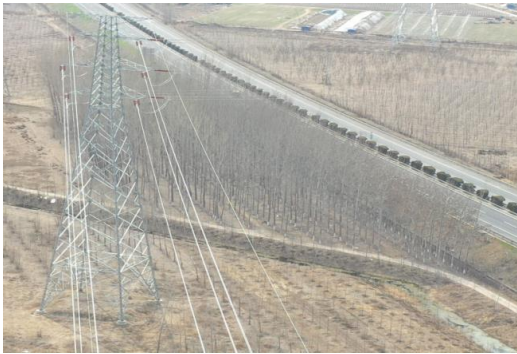
图 8-7 津蓟高速公路西侧塔基施工区恢复现状
