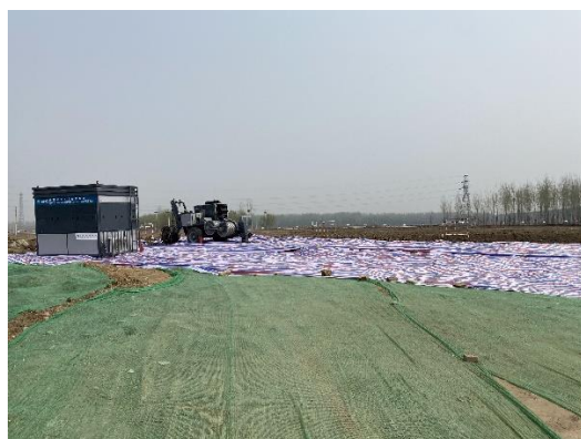
图 8-2 施工期生态保护措施 2
