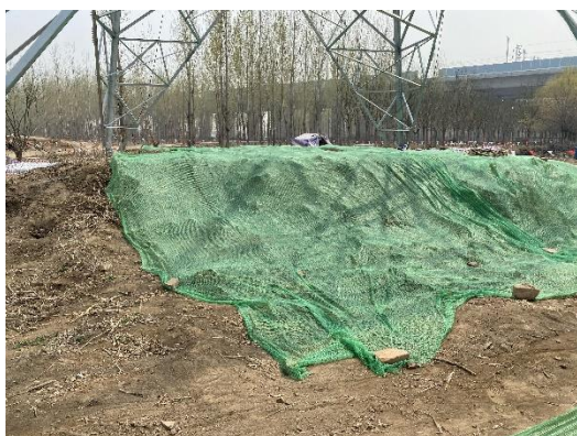
图 8-1 施工期生态保护措施 1
