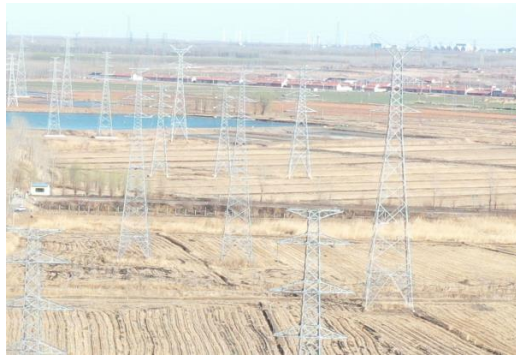
图 8-7 津蓟铁路西侧塔基施工区恢复现状
