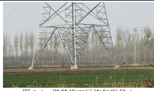
图 8-6 塔基施工区恢复现状 4
