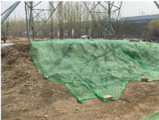
图 8-1 施工期生态保护措施 1
