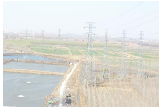
图 8-10 引滦水源输水河道黄线区东侧塔基施工区恢复现状 2
