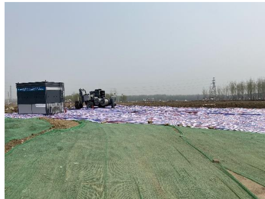
图 8-2 施工期生态保护措施 2
