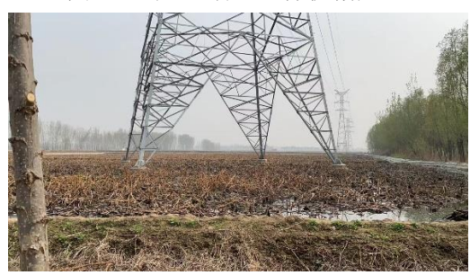
图 8-4 塔基施工区恢复现状 2
