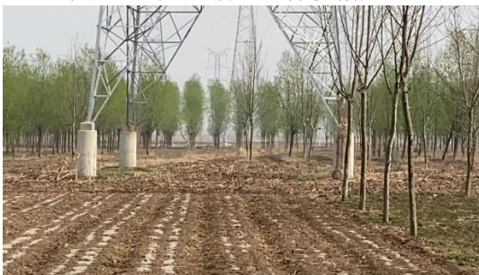
图 8-3 塔基施工区恢复现状 1
