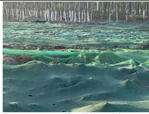
图 8-12 施工期绿网覆盖
