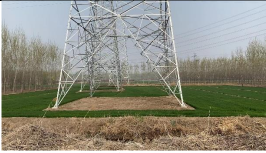
图 8-5 塔基施工区恢复现状 3
