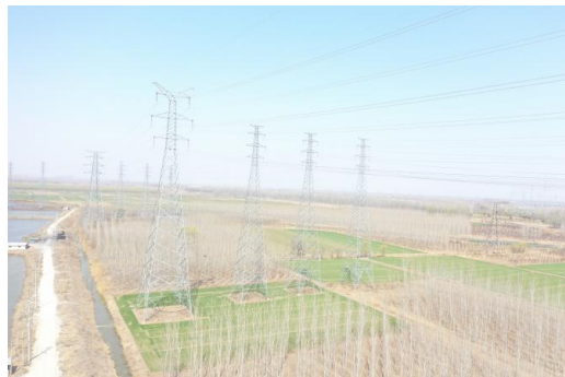
图 8-9 引滦水源输水河道黄线区东侧塔基施工区恢复现状 1
