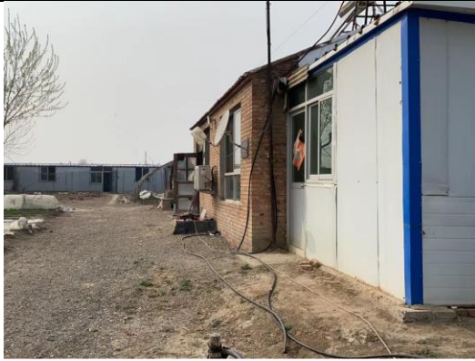
图 2-1 津围公路西侧民房
