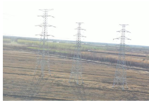
图 8-8 津蓟铁路东侧塔基施工区恢复现状
