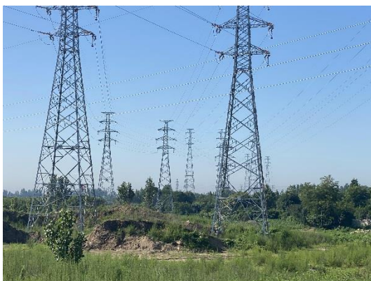
图 8-6 塔基恢复现状 (4)
