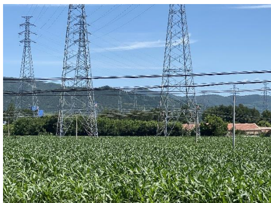
图 8-5 塔基恢复现状 (3)
