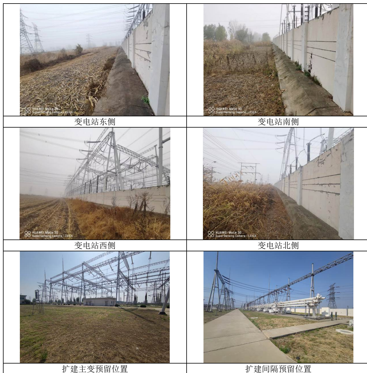
图 4.1-1 现状变电站四侧厂界及本期扩建预留位置现状照片
