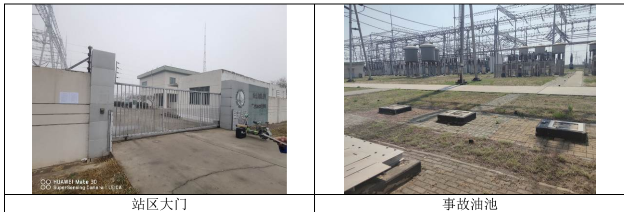
图 3.1-1 现状变电站现场照片
