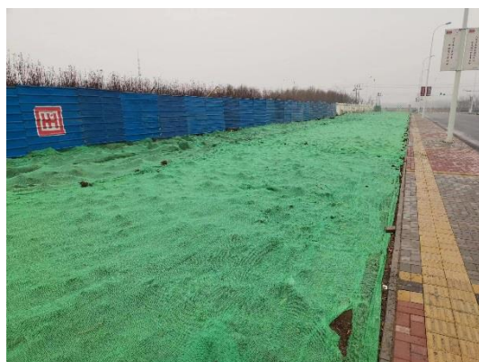
图 8-5 施工现场情况 (1)
