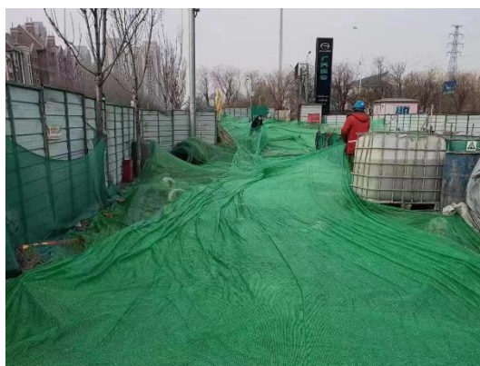
图 8-6 施工现场情况 (2)
