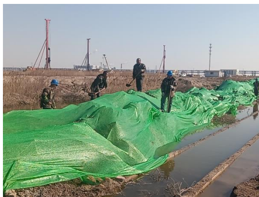
图 8-8 施工现场情况（4）
