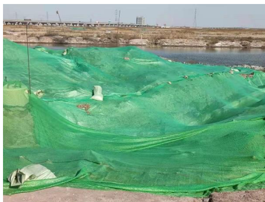
图 8-6 施工现场情况 (2)
