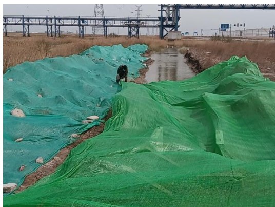
图 8-7 施工现场情况（3）
