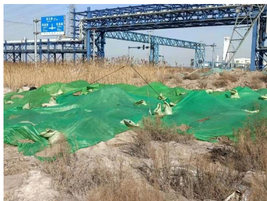
图 8-5 施工现场情况 (1)
