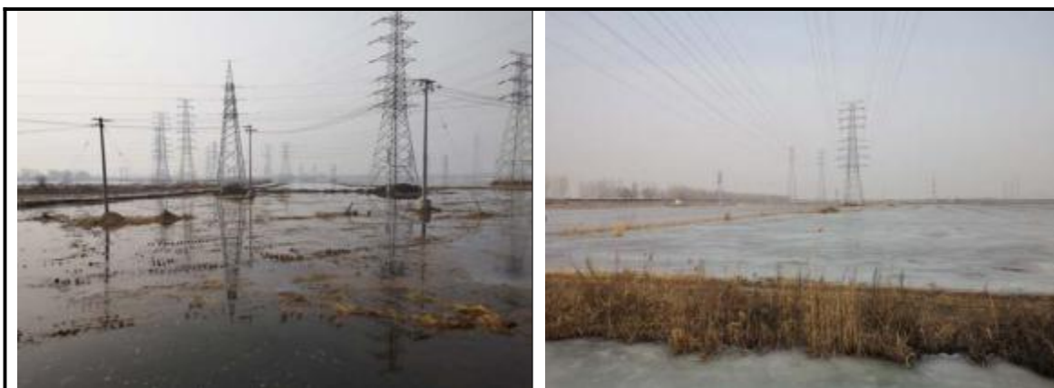
2022.12~项目完工期间
