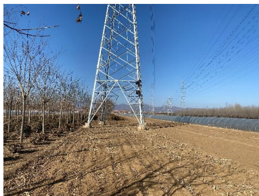
京秦铁路防护林带北侧
