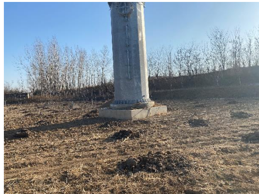
津蓟高速公路西侧防护林带新建铁塔 2
