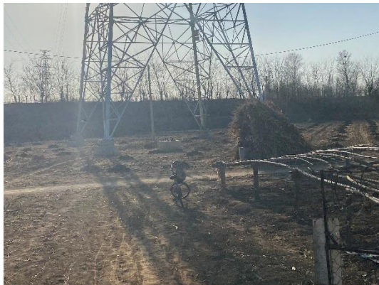
津蓟高速公路西侧防护林带新建铁塔 1
