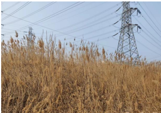
盛塘路站至盛万西花园站 110 千伏线路工程电缆沿线
