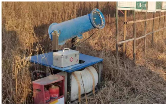
施工期除尘雾炮机
