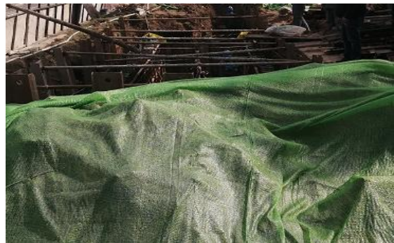
电缆施工围挡及土壤分层堆放苫盖照片
