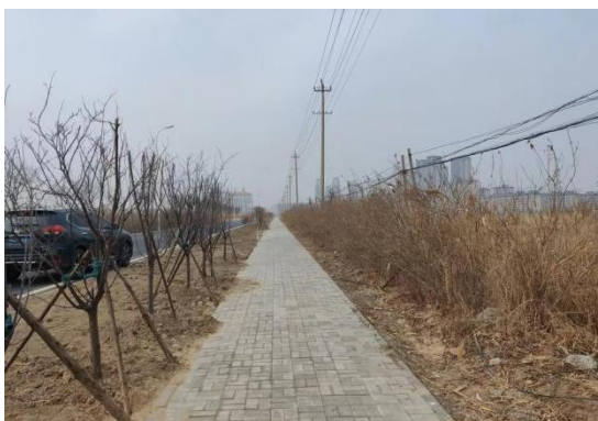
盛塘路站至天嘉湖站 110 千伏线路工程电缆沿线
