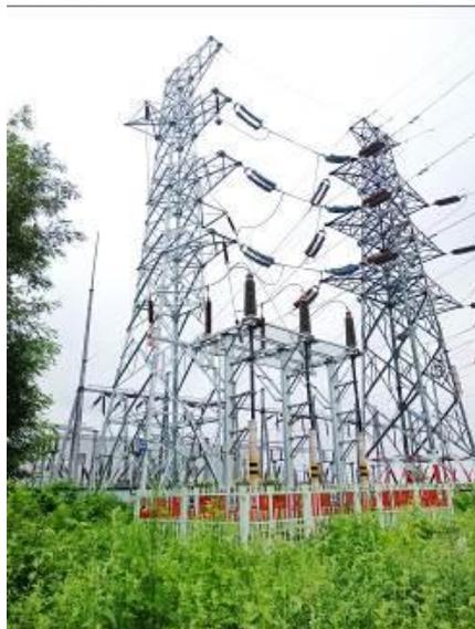
C1 电缆终端塔及架空线路
