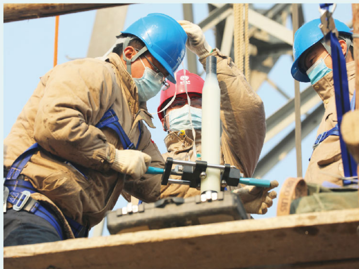
自主完成110kV本型线电缆终端塔缺陷处理工作
