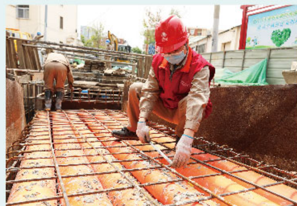
老旧电缆改造工程获评“优质工程”
