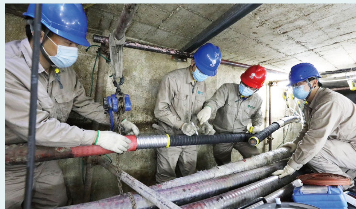
自主完成110千伏浚湘一二线中间接头缺陷处理
