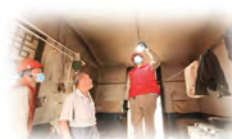
党员服务队为困难户安装节能灯
