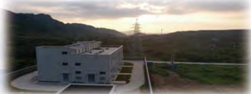
青山35千伏输变电投产送电
