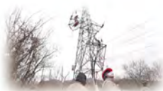
开展电网设备升级改造
