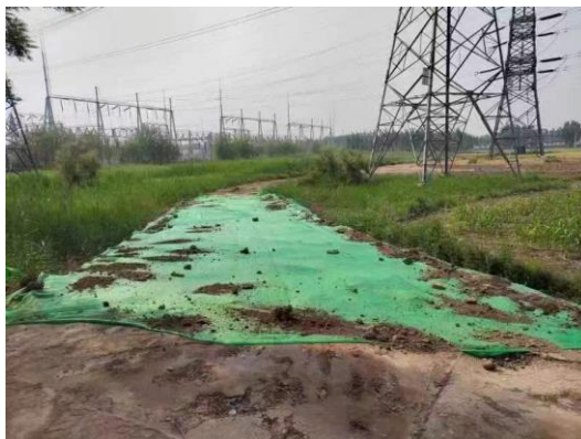
图 8-3 施工现场情况
