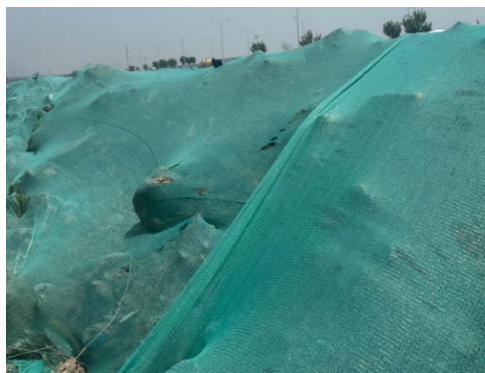
临时堆土密目网苫盖
