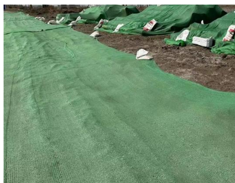
裸露地表及物料密目网苫盖
