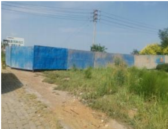
施工场地周边围挡
