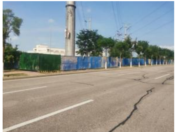
施工场地周边围挡
