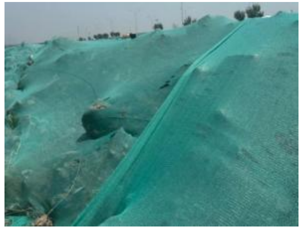
临时堆土密目网苫盖
