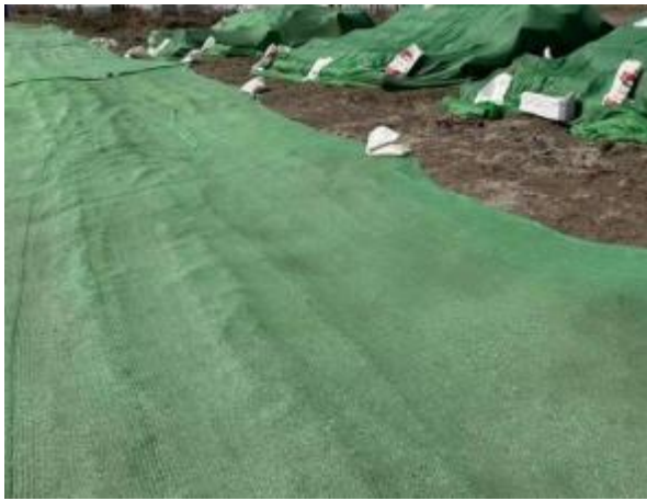
裸露地表及施工物料密目网苫盖
