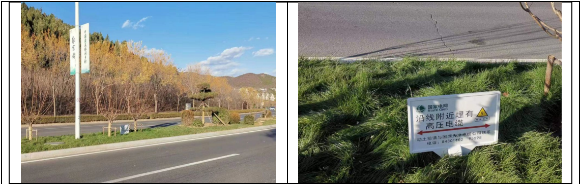
电缆线路沿线植被恢复情况
