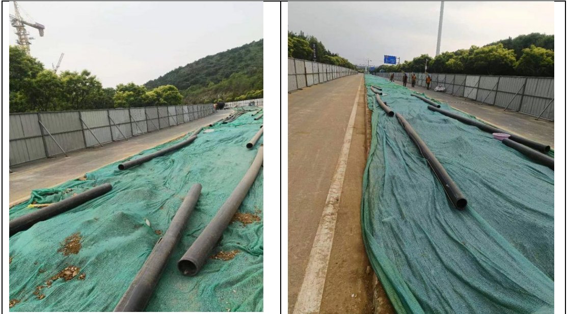
施工围挡及苫盖
