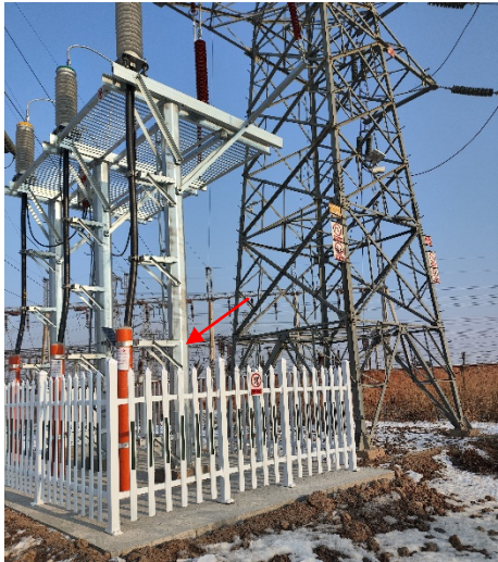
新建电缆终端平台及生态现状
