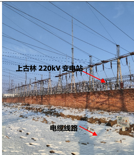
电缆线路与变电站的关系
