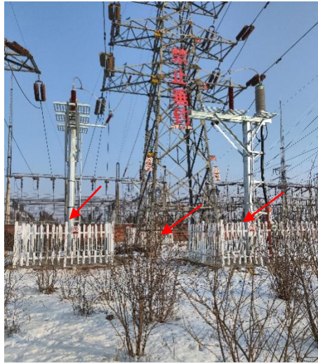
新建电缆终端平台及生态现状
