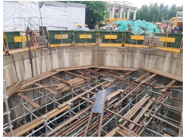
电缆隧道工作井
