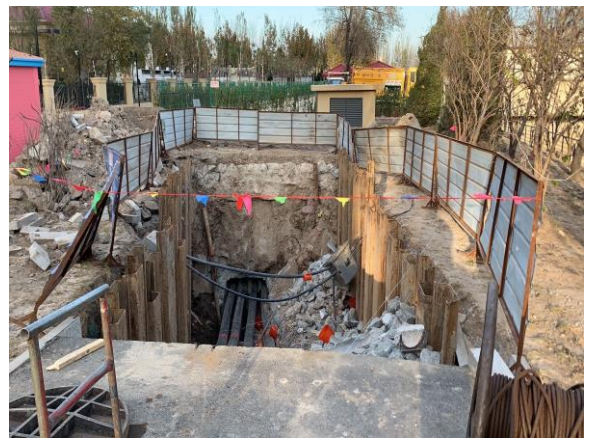
电缆排管施工情况
