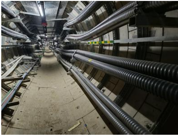
利用已建隧道敷设电缆
