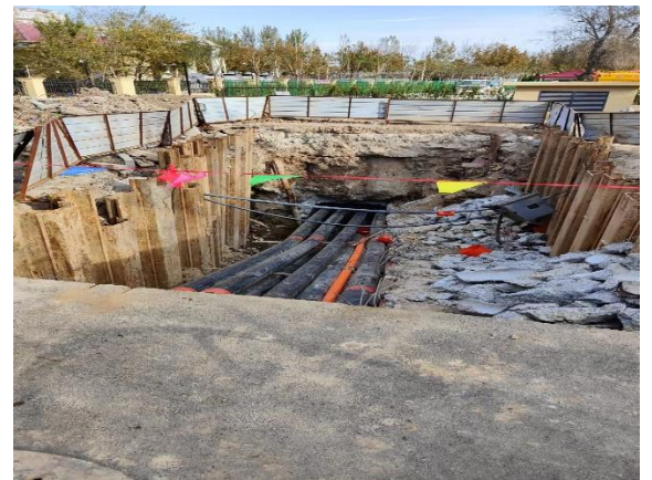
电缆排管施工情况
