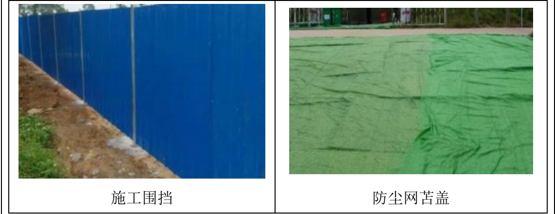
图 6-2 施工期环保措施照片
