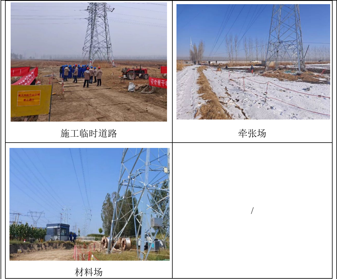
图 6-1 施工临时占地照片
