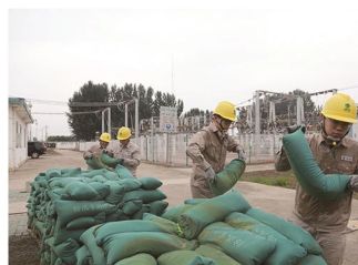
变电运检室运维人员对110千伏下仓变电站等低洼站所进行沙包封堵
