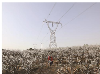
沙尘天气巡视输电线路、铁塔
