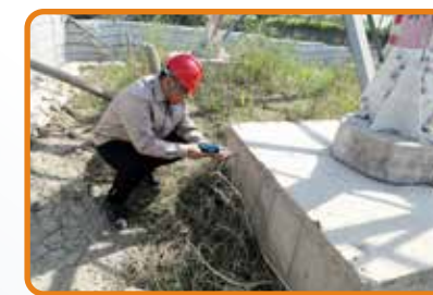
混凝土回弹仪 检测基础混凝土、保护帽
