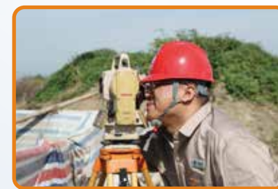
塔基全站测量仪 检测杆塔倾斜度
