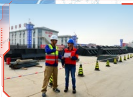
为国家高铁网重要组成部分——津潍高铁建设提供可靠电力保障，加强天津与山东半岛、长三角的互联互通，助力京津冀协同发展“列车”越跑越快
