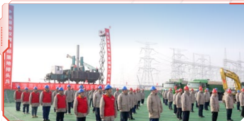
开工天津南 1000 千伏特高压变电站扩建工程，加快融入京津冀特高压环网
