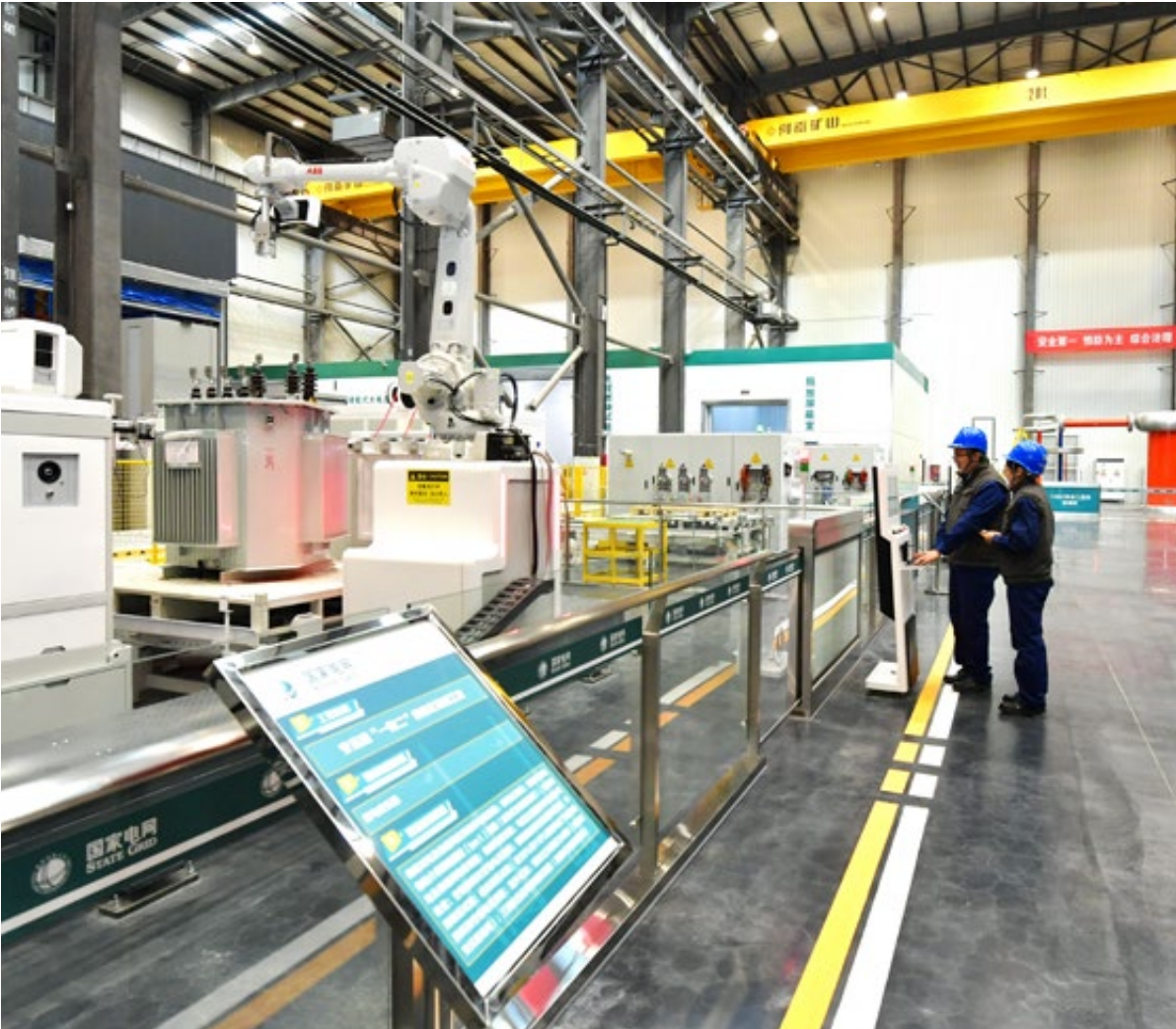
具备“采检储运”一体化运营功能的综合性供应链服务智慧园区——国网天津电力供应链智慧园区建成运营
