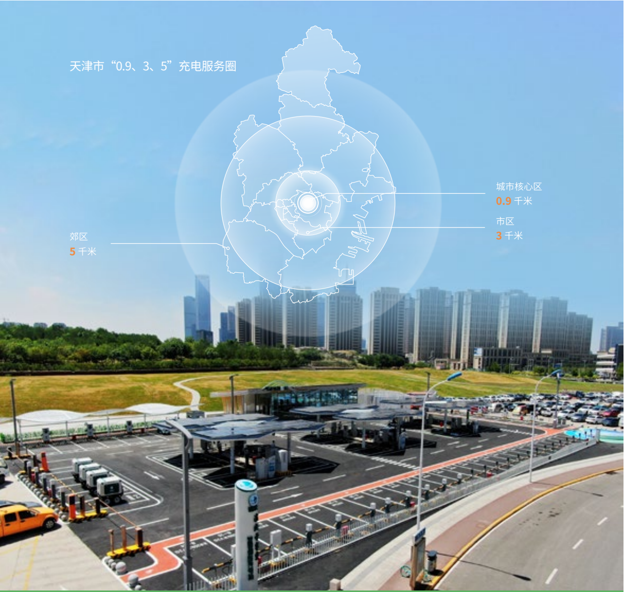
天津市滨海新区规模最大的集中式电动汽车充电站——天津滨海于家堡双碳创新充电站建成投用
