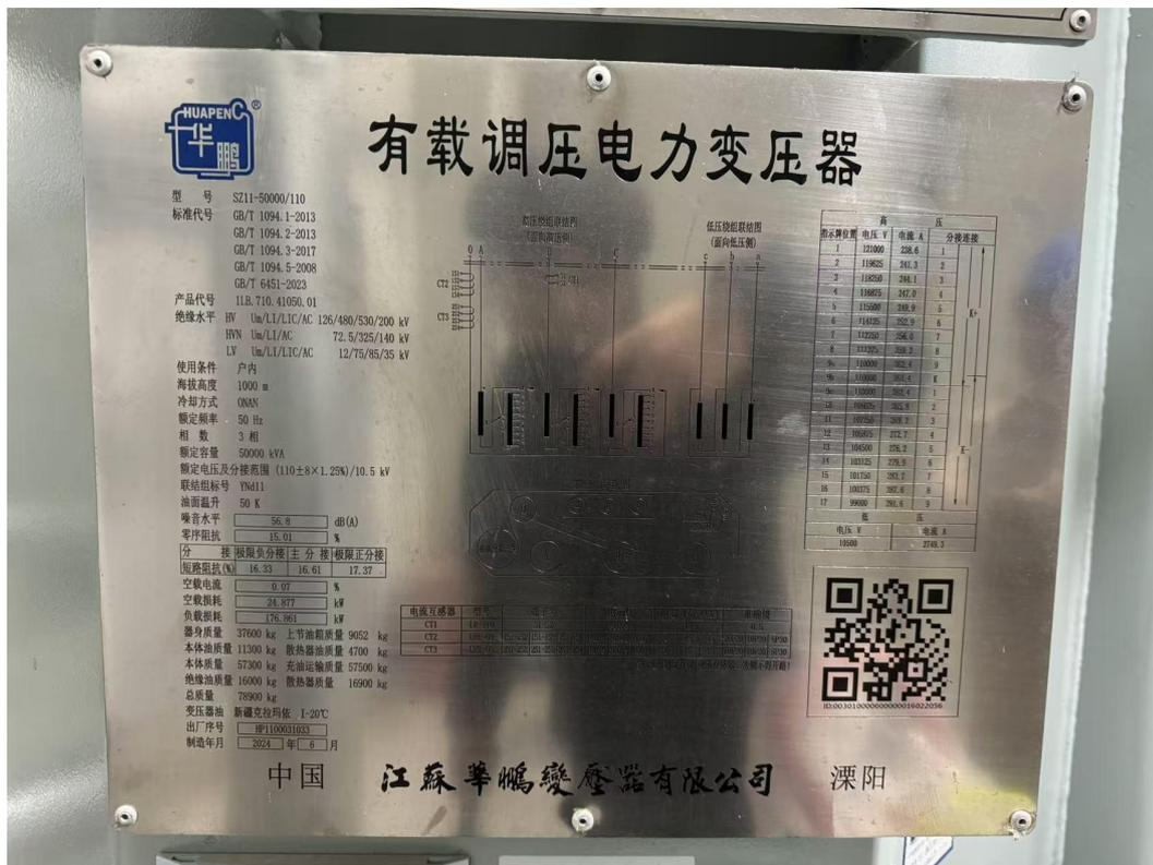
图 8-1 变压器铭牌（1 号和 2 号主变型号一致）
