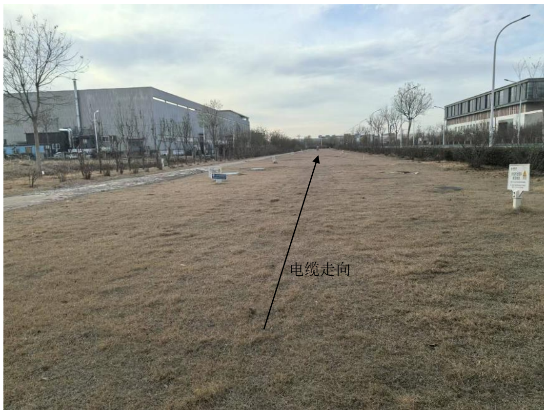
敷设电缆处现状
