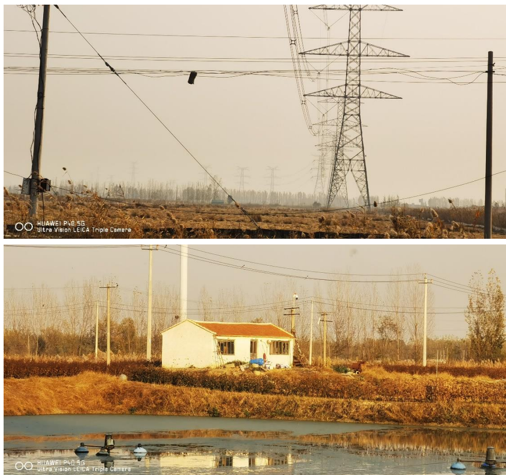
图 4.2-2 天津北~芦台 500kV 线路沿线地形地貌典型照片
