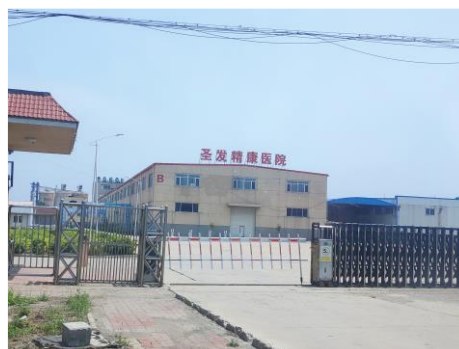
重建变电站东北侧-圣发精康医院
