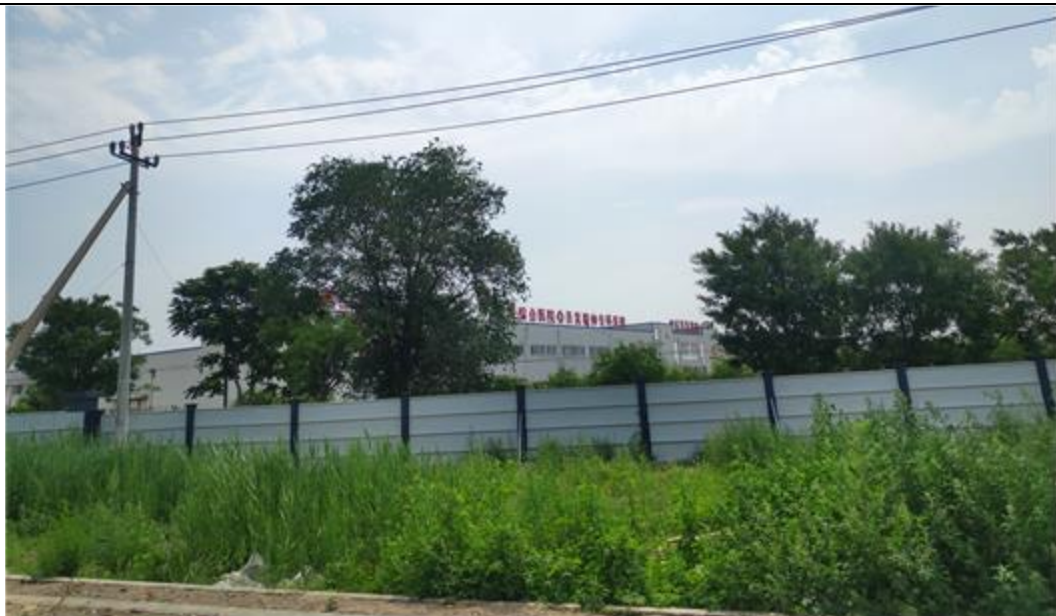
图 7-1 变电站东侧围墙外 10kV 线路
