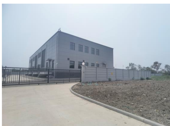
变电站外西侧
