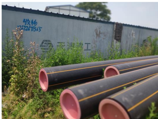
变电站北侧天津建工施工项目部
