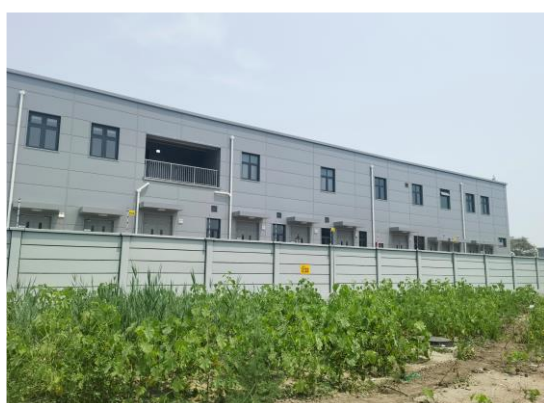
变电站外南侧
