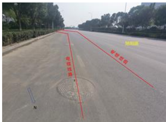
电缆线路沿线
