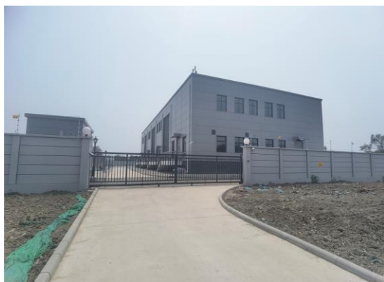
重建么六桥 110kV 变电站
