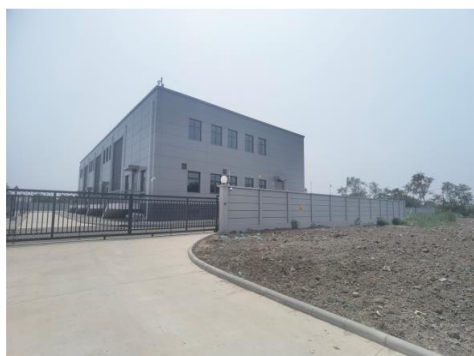
重建么六桥变电站
