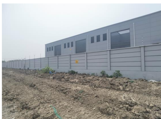
变电站外北侧
