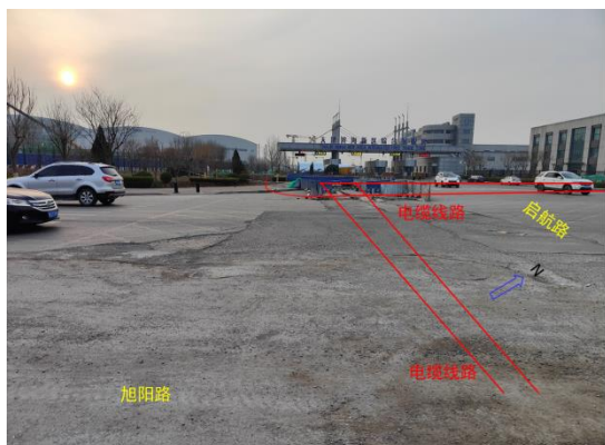
电缆线路沿线
