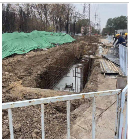
电缆施工限界、密目网苫盖
