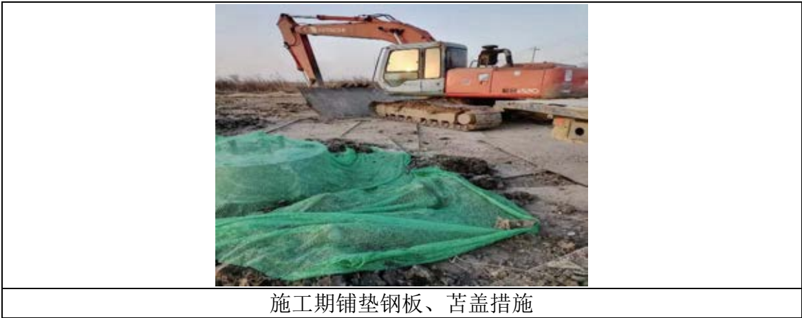
图 6-1 本项目施工期间采取的环保措施
