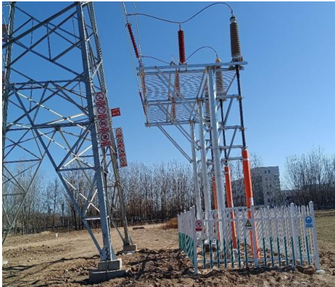
新建电缆终端终端平台周边恢复情况
