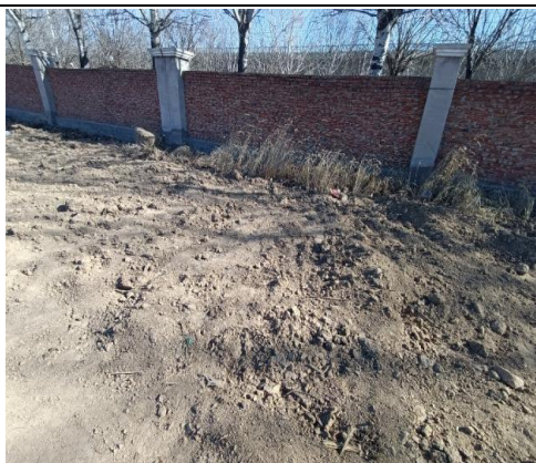
新建电缆沿线土方平整
