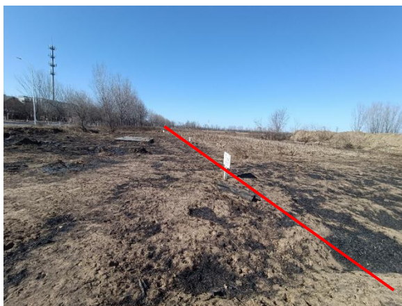
利用现状电缆通道沿线
