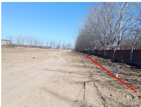
新建电缆沿线
