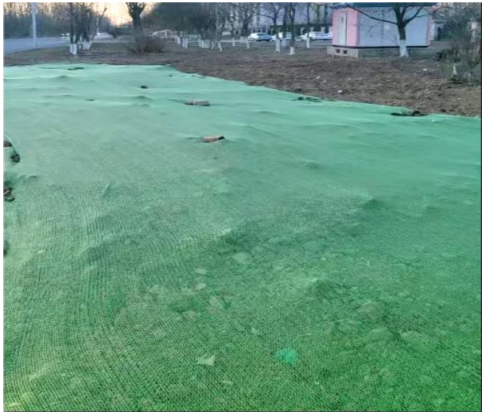
新建电缆采用密目网苫盖
