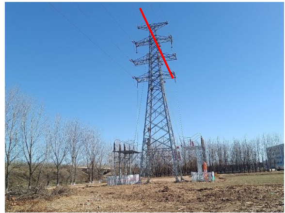
利用已建铁塔单侧挂线
