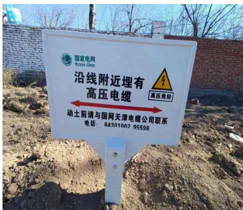
新建电缆标识牌
