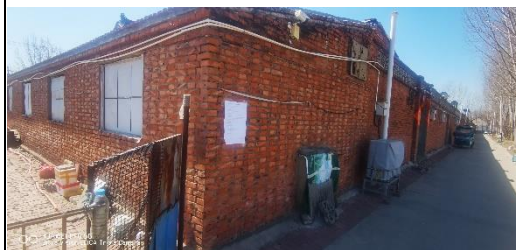
宝坻区大钟庄镇大苑庄村居民住宅
